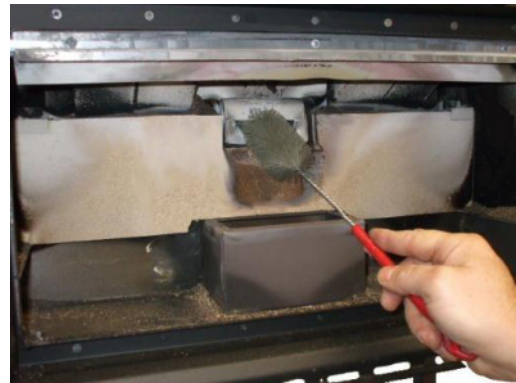
Fig. 49 - Reiniging met flessenwisser
