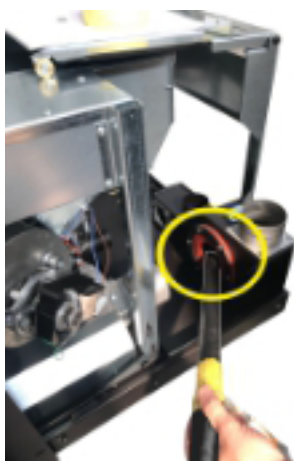
Fig. 115 - Pulizia canale da fumo
