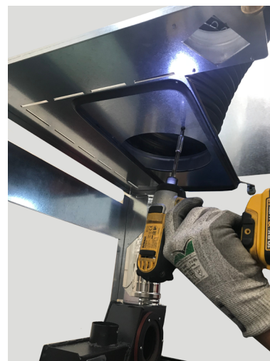
Fig. 69 - Fissaggio tubo flessibile
