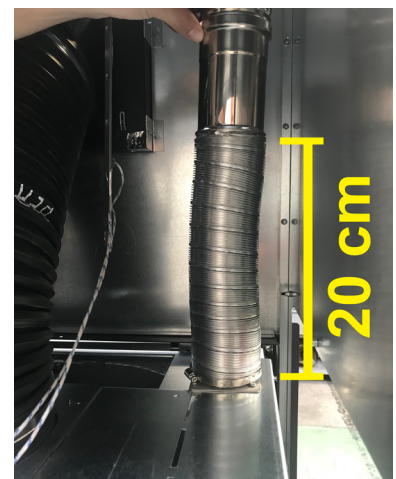
Fig. 49 - Collegamento tubo flessibile (vista posteriore dell'inserto)
