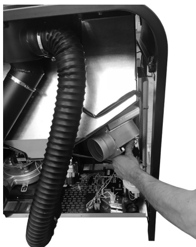
Fig. 35 - Fastgør skærmen og ventilatoren til ovnen
