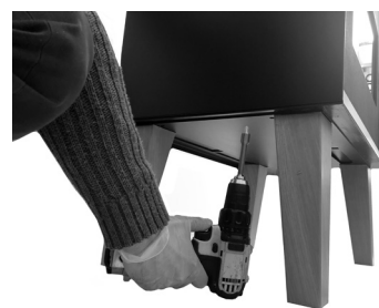
Fig. 19 - Fastgøring af ovn
