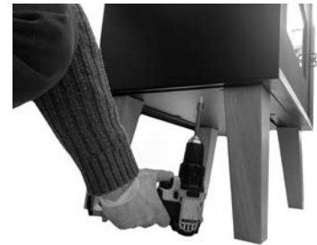
Fig. 19 - Befestigung des Ofens
