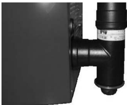
Fig. 64 - Reinigung des Rauchgaskanals
