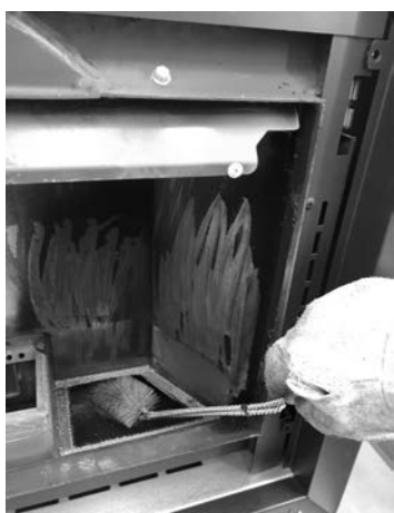
Fig. 68 - Mit einer Rohrreinigungsbürste reinigen
