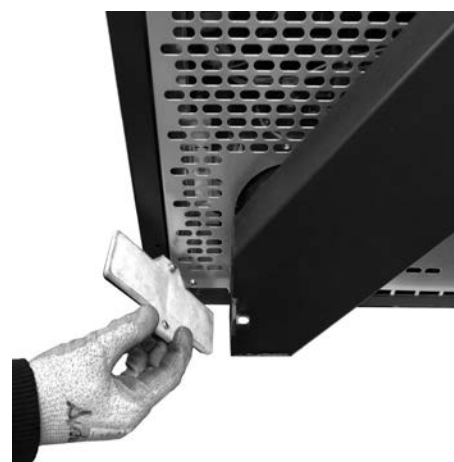
Fig. 65 - Reinigung des Rauchgaskanals
