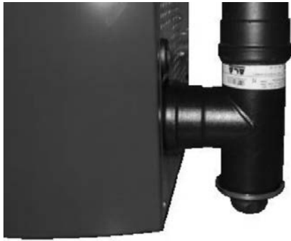
Fig. 64 - Fume conduit cleaning
