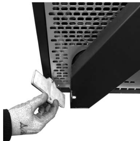
Fig. 65 - Reiniging rookleiding
