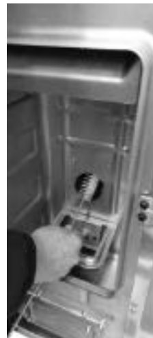
Fig. 38 - Nettoyage avec nettoie-pipes
