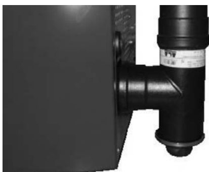
Fig. 64 - Pulizia canale da fumo
