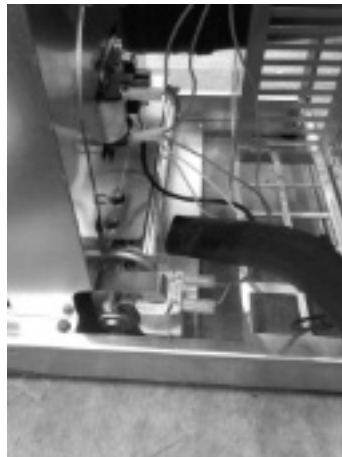
Fig. 34 - Limpieza ventilador ambiente
