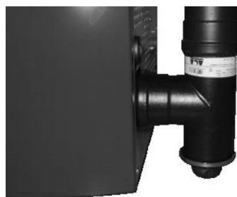
Fig. 27 - Fume conduit cleaning
