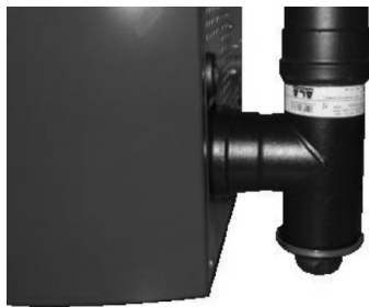
Fig. 30 - Nettoyage du conduit de fumée
