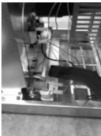
Fig. 32 - Pulizia ventilatore ambiente
