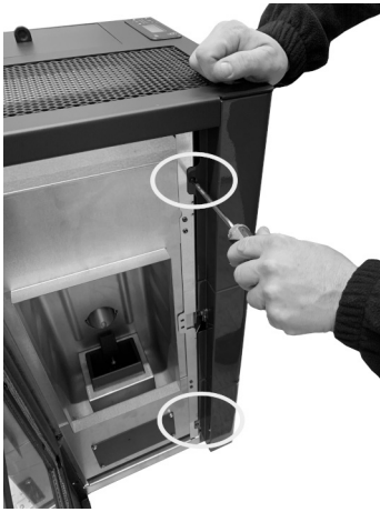
Fig. 34 - Retire los tornillos
