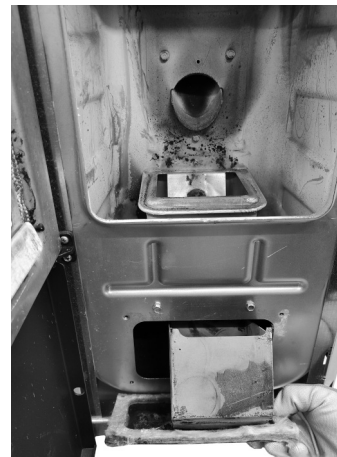
Fig. 71 - Retire la tapa de inspección
