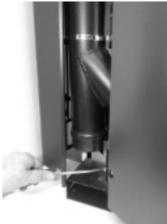
Fig. 68 - Desatornille el tope de la tapa
