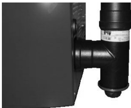
Fig. 66 - Limpieza canal de humos
