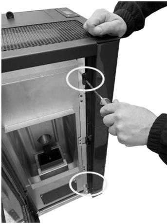
Fig. 34 - Schrauben lösen
