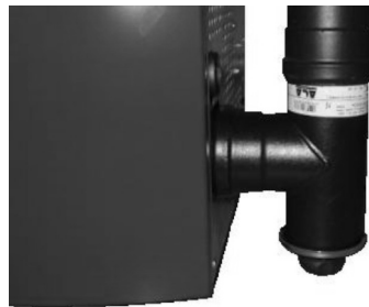
Fig. 66 - Reiniging rookleiding
