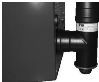
Fig. 77 - Nettoyage du conduit de fumée
