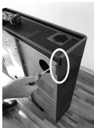
Fig. 34 - Fije los tornillos
