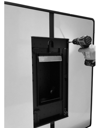
Fig. 40 - Fijación del revestimiento
