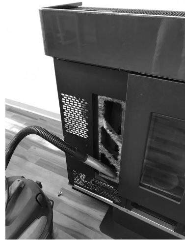
Fig. 61 - Limpieza cámara de humos
