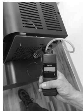
Fig. 49 - Conexión del presostato digital
