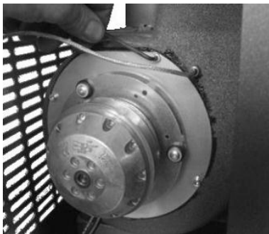
Fig. 55 - Limpieza del aspirador de humos: fase 1
