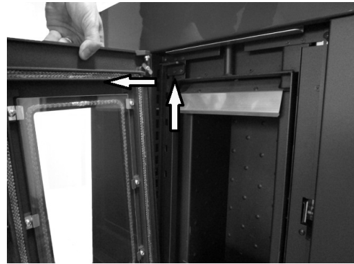
Fig. 27 - Desmontaje de la puerta
