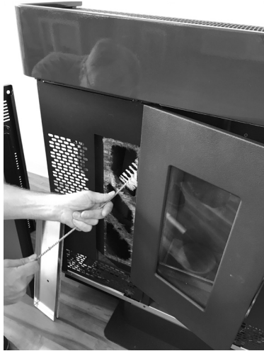
Fig. 60 - Limpieza con escobilla
