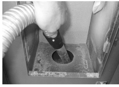
Fig. 39 - Limpieza alojamiento brasero
