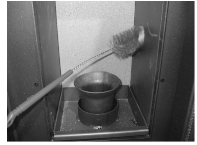
Fig. 40 - Limpieza con escobilla
