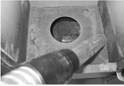
Fig. 38 - Limpieza alojamiento cajón de cenizas
