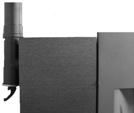
Fig. 60 - Fume conduit cleaning
