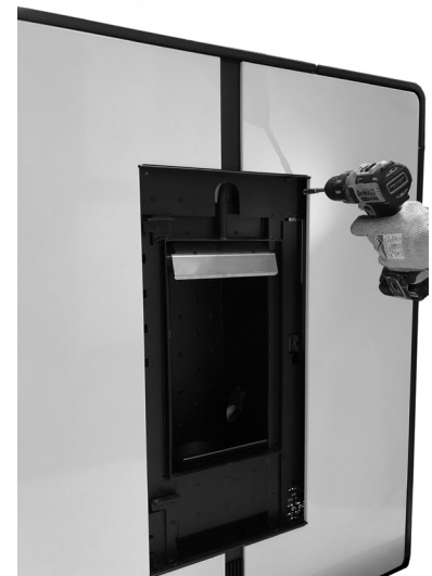
Fig. 38 - Bevestiging bekleding
