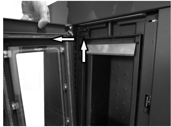
Fig. 25 - Verwijdering van de deur
