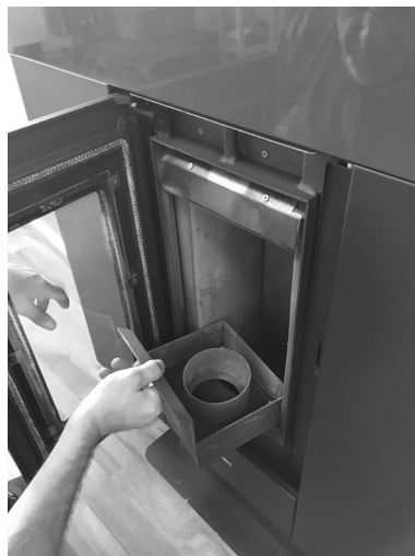
Fig. 36 - Reiniging vuurpot
