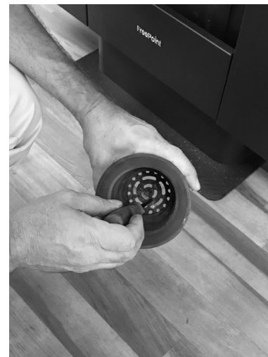
Fig. 37 - Reiniging vuurpot
