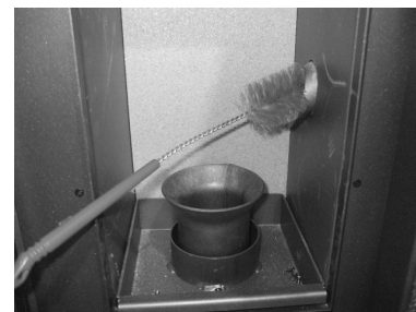
Fig. 40 - Reiniging met flessenwisser
