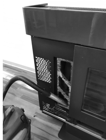
Fig. 68 - Nettoyage de la chambre des fumées
