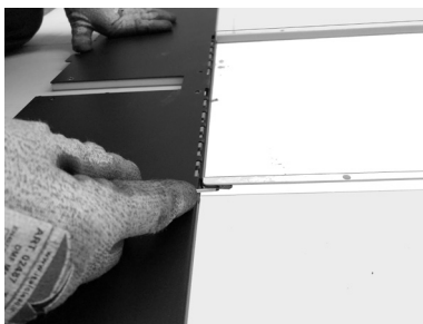
Fig. 45 - Pliage des dents
