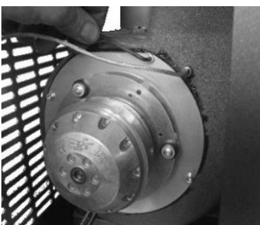
Fig. 62 - Nettoyage de l'aspirateur des fumées: phase 1
