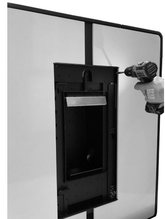
Fig. 47 - Fixation du revêtement
