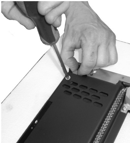
Fig. 33 - Türverriegelungsstift befestigen
