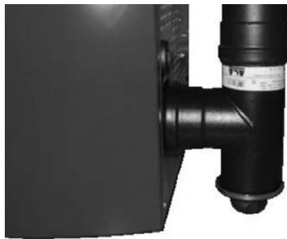
Fig. 37 - Reiniging rookleiding
