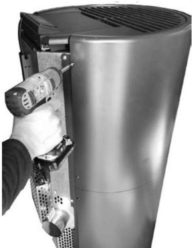
Fig. 24 - Verwijdering achterste schroeven
