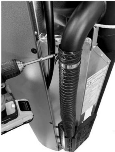
**Fig. 32 - Retire el tubo flexible**
