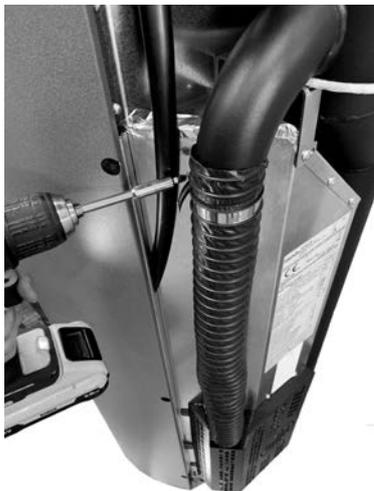
Fig. 30 - Schlauch herausziehen
