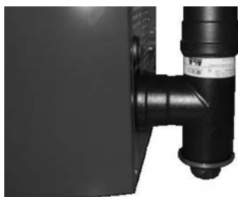
Fig. 46 - Nettoyage du conduit de fumée
