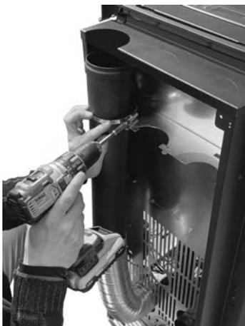
**Fig. 65 - Bloqueo del tubo d. 80 mm**
