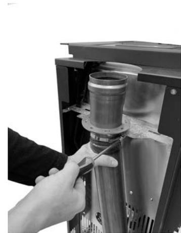
**Fig. 44 - Bloqueo con abrazadera**
