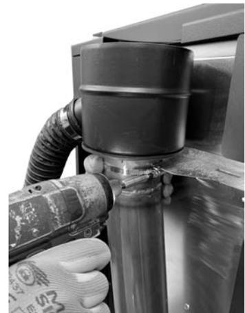
**Fig. 50 - Bloqueo con abrazadera**
