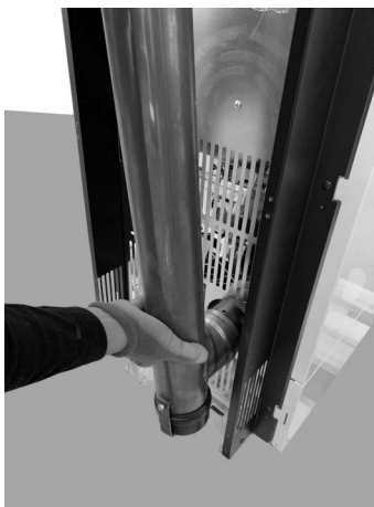
Fig. 41 - Insert pipe d.80 mm
