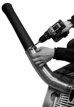
**Fig. 61 - Collegare tubo d.80 mm**
