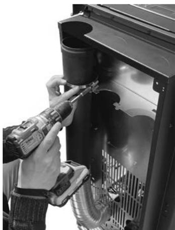
**Fig. 63 - Bloccare tubo d.80 mm**
