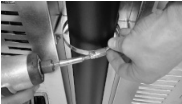
Fig. 58 - Blokkeer met klem
