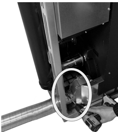
Fig. 66 - Flexibele buis vastzetten
