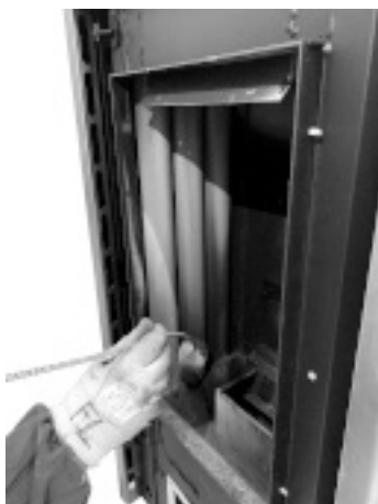
Fig. 89 - Reinig met pijpenwisser
