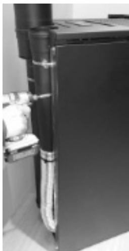
Fig. 20 - Achterste schroeven verwijderen
