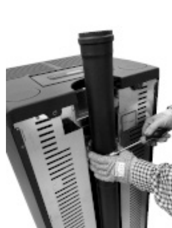
Fig. 54 - Rookgassenafvoer achteraan gemonteerd
