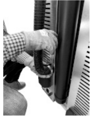
Fig. 57 - Koppel de buis van de verbrandingslucht
