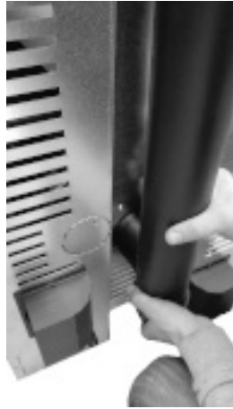
Fig. 56 - Koppel de buis met diameter 80 mm
