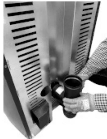
**Fig. 41 - Conecte el racor en T**
