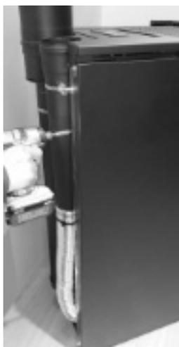
*Fig. 25 - Extracción de los tornillos traseros*
