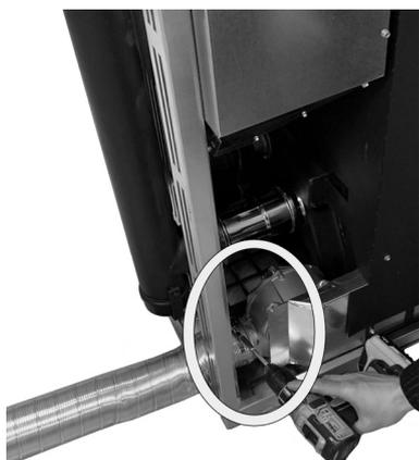
**Fig. 56 - Bloquee el tubo flexible**
