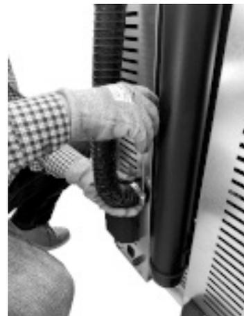
**Fig. 47 - Acople el tubo de aire comburente**
