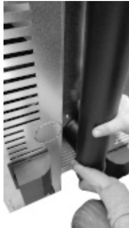
Fig. 51 - Raccorder le tuyau d.80 mm
