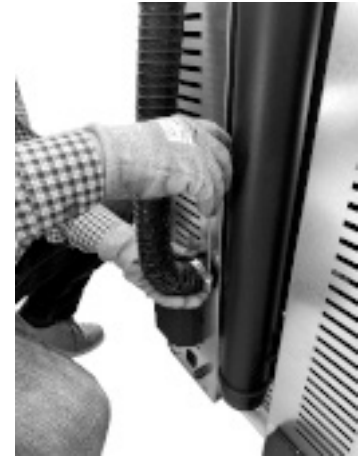
Fig. 52 - Raccorder le tuyau de l'air comburant
