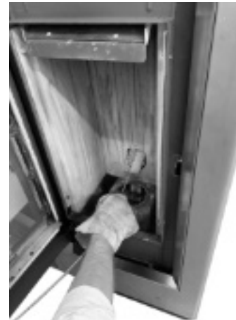
Fig. 36 - Nettoyage avec nettoie-pipes
