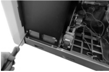
Fig. 95 - Room fan cleaning
