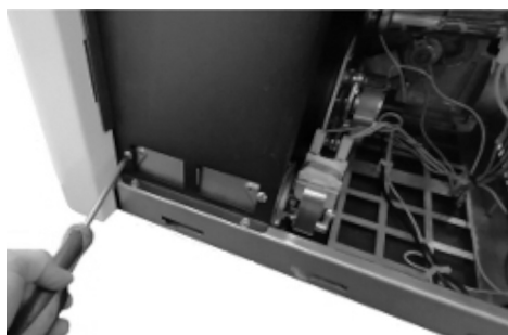
Fig. 44 - Pulizia ventilatore ambiente
