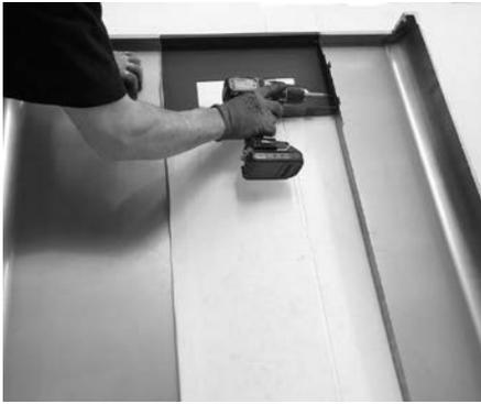
Fig. 31 - Fijación del montante
