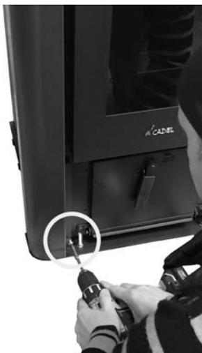
**Fig. 14 - Fijación del marco**
