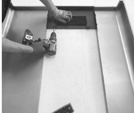
Fig. 32 - Fijación de la rejilla
