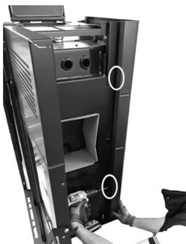
Fig. 48 - Fijación delantera del lateral
