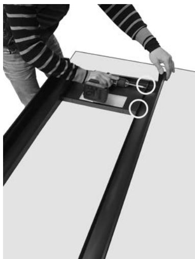
Fig. 11 - Bevestiging van het opstaand element
