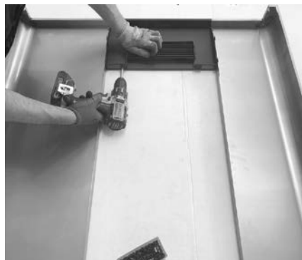
Fig. 32 - Bevestiging van de rooster
