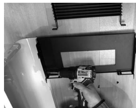
Fig. 19 - Bevestig het paneel op de stijl
