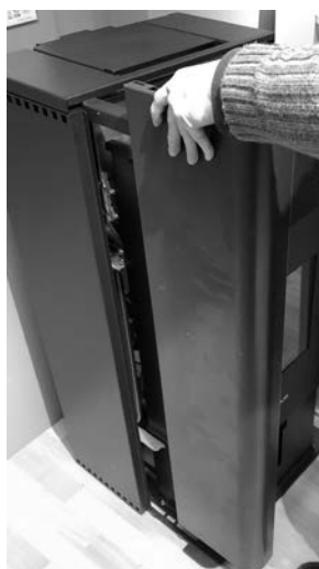
Fig. 20 - Haak de lijst vast in de zittingen van de kachel
