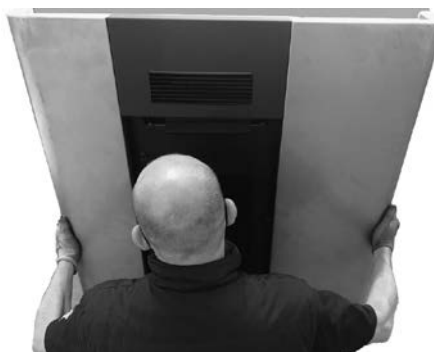
Fig. 35 - Positionering van de lijst
