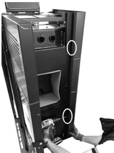
Fig. 48 - Bevestiging vooraan zijpaneel
