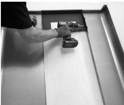
Fig. 31 - Bevestiging van het opstaand element
