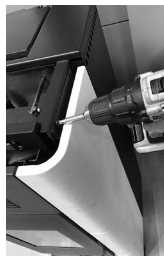
Fig. 27 - Bevestiging op het paneel
