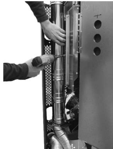
Fig. 71 - Fijación del tubo
