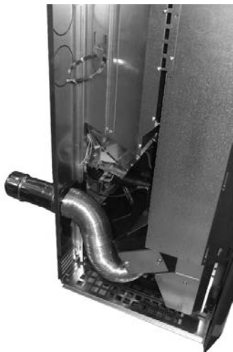
Fig. 65 - Posicionamiento posterior de los tubos
