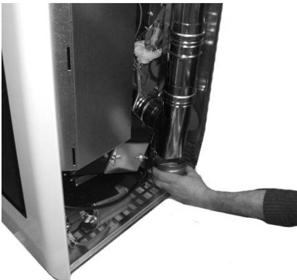
Fig. 109 - Limpieza canal de humos
