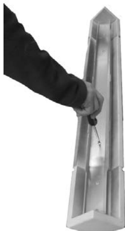
Fig. 41 - Atornille el perfil en las mayólicas
