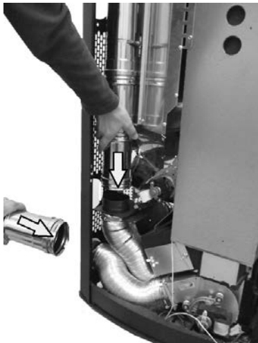
Fig. 70 - Colocación de los tubos de canalización
