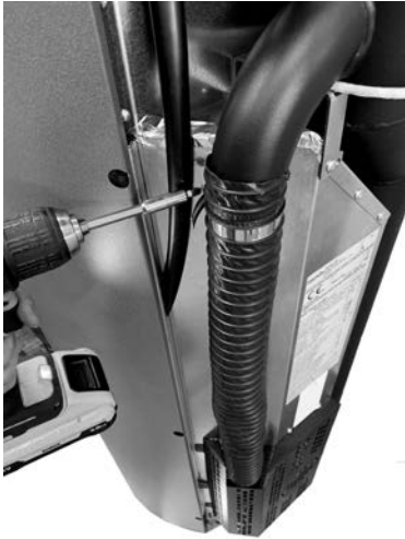
Fig. 77 - Schlauch herausziehen
