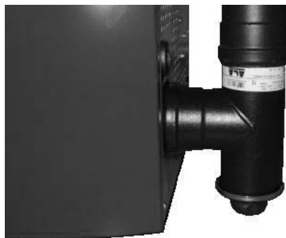
Fig. 84 - Reinigung des Rauchgaskanals
