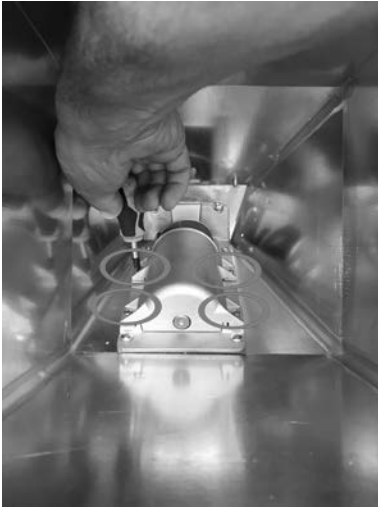
Fig. 80 - Extracción de los tornillos
