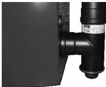
Fig. 85 - Limpieza canal de humos
