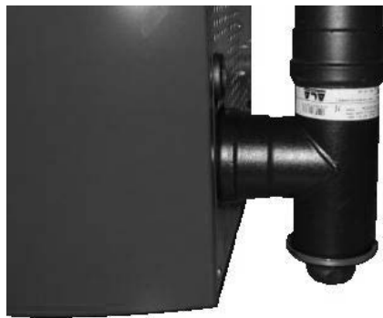
Fig. 85 - Fume conduit cleaning
