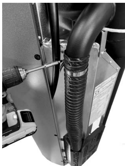
Fig. 78 - Flexibele buis naar buiten trekken
