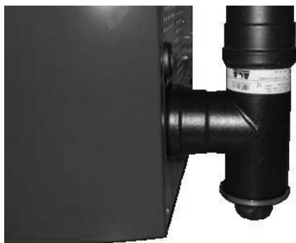
Fig. 90 - Nettoyage du conduit de fumée
