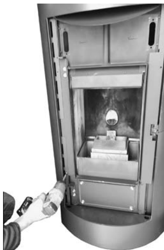
Fig. 65 - Rimozione viti profili (dx e sx).
