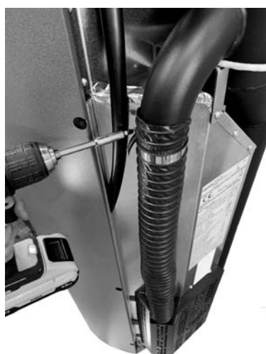
Fig. 78 - Sfilare tubo flessibile
